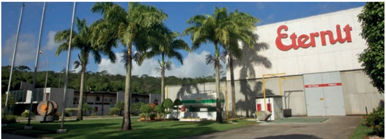
Eternit Simões Filho Plant in Bahia
